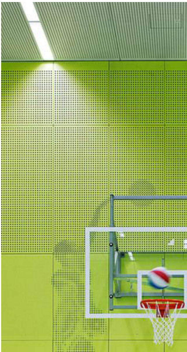
trattamento fonoassorbenti verticali nella palestra
